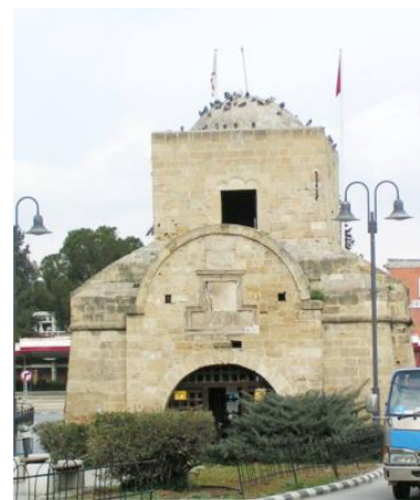
fot.2. Brama Kireńska w Nikozji, zbudowana przez Wenecjan w XVI w.
